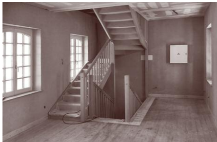
1 re et 2 e photos Travaux d'aménagement de l'entrée piétonne avant et après travaux © ENSA Normandie
