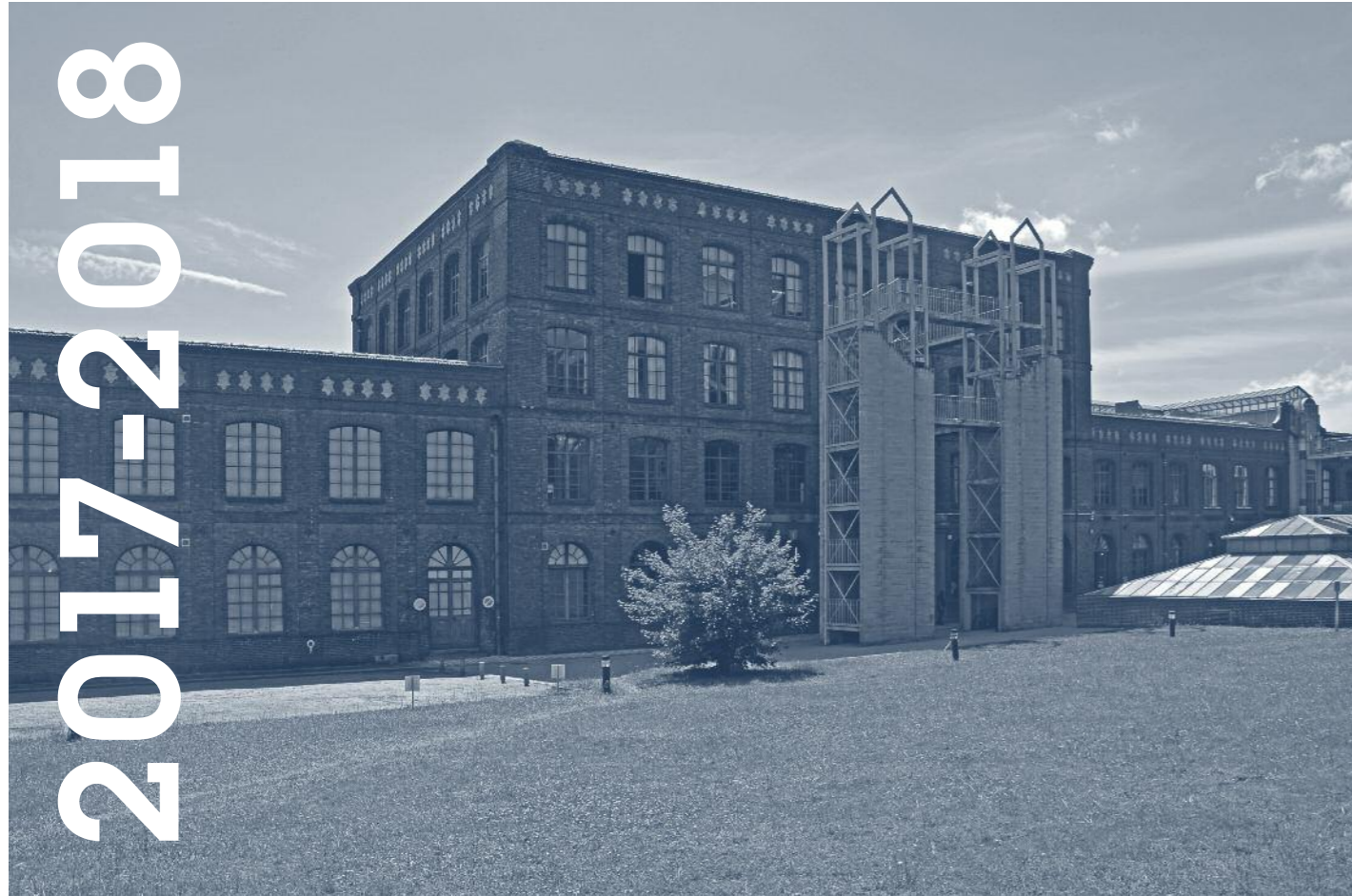
Vue extérieure bâtiment principal © ENSA Normandie
