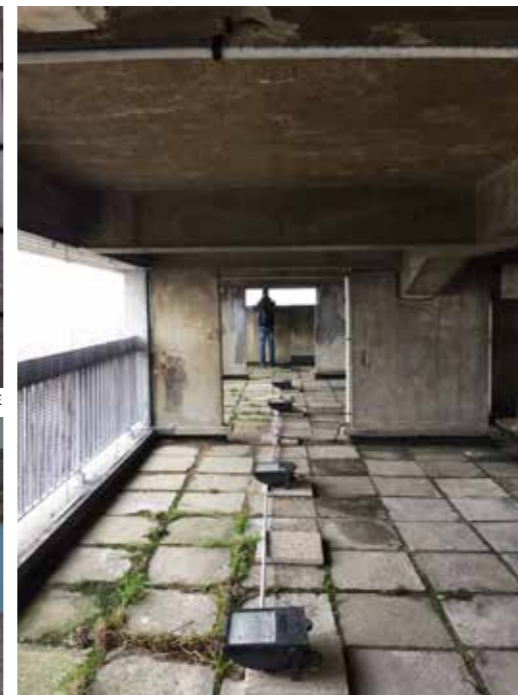
NIVEAU INFÉRIEUR AU RÉSERVOIR
