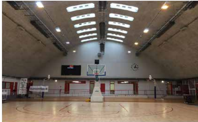
VOÛTE EN BÉTON
