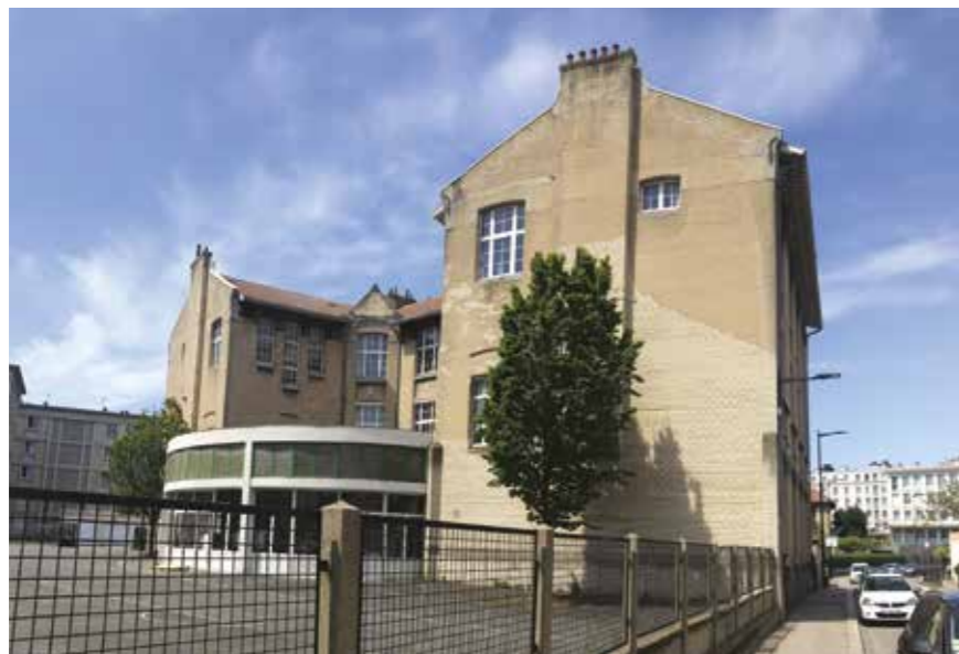
FAÇADE SUD DE L'ÉCOLE JEAN MACÉ
