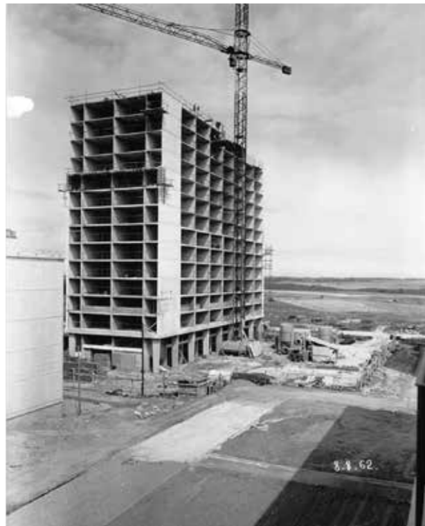
CONSTRUCTION DE LA TOUR RÉSERVOIR, 1962
