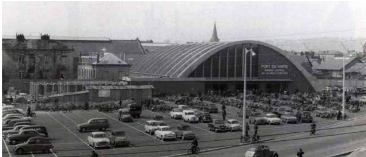
HALLE DU PORT DU HAVRE, BCMO
