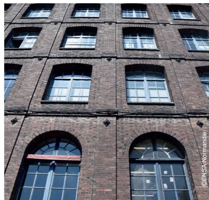
Façade côté rue du Robec
