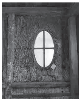
Figure 6: Détail du revêtement intérieur
