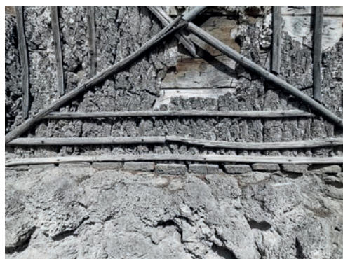
Figure 4: Le socle en pierre surmonté d'une rangé de briques
