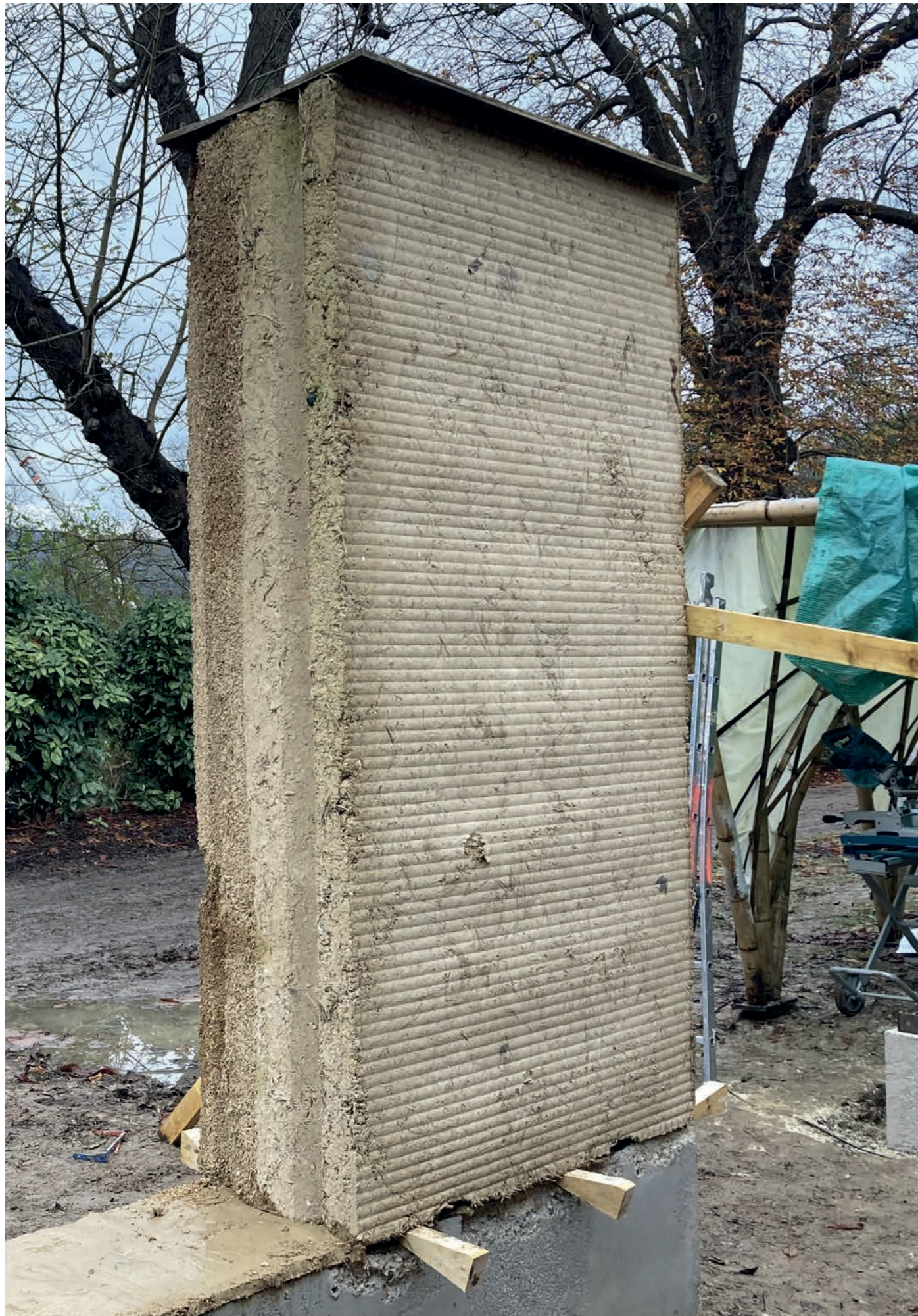
Fig.35 - Premier bloc CobBauge levé et façade texturée de la bauge 38
