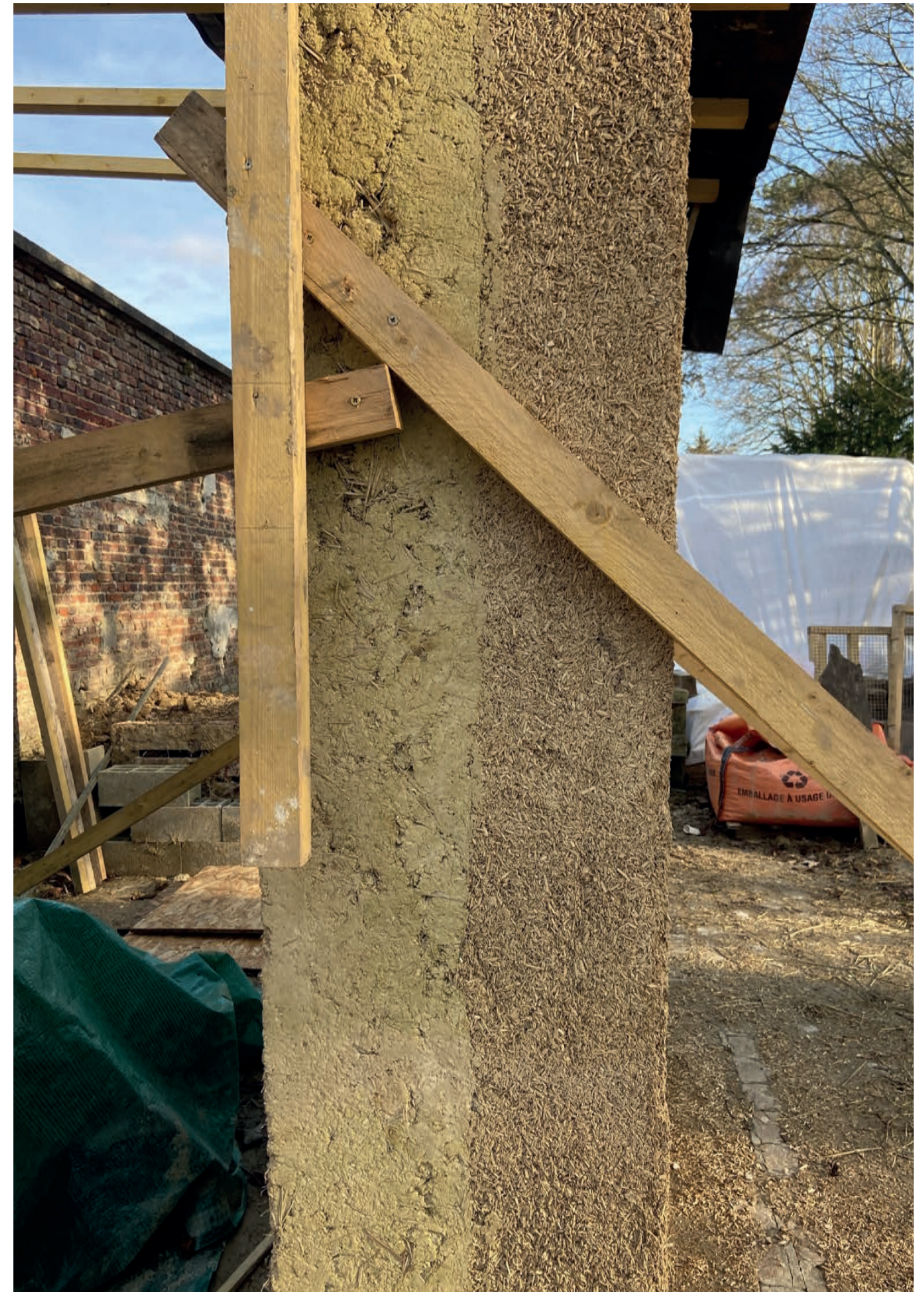
Fig.34 - Coté latéral du mur levé montrant la composition CobBauge
