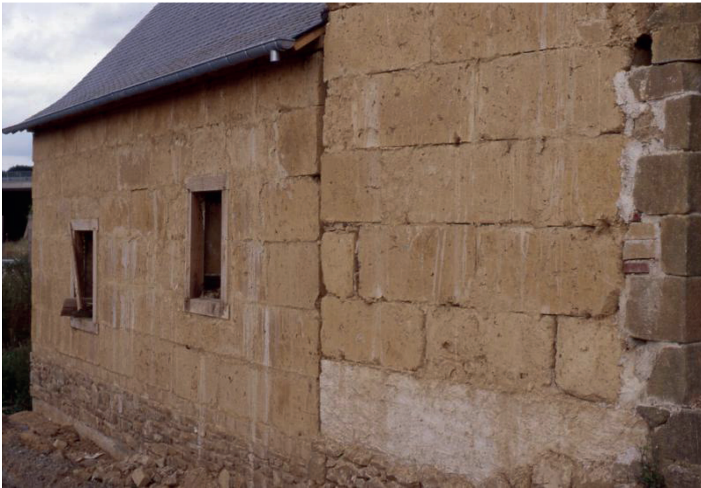
Fig.6 - Façade composée des blocs préfabriqués mis au point par Jean Guillorel
