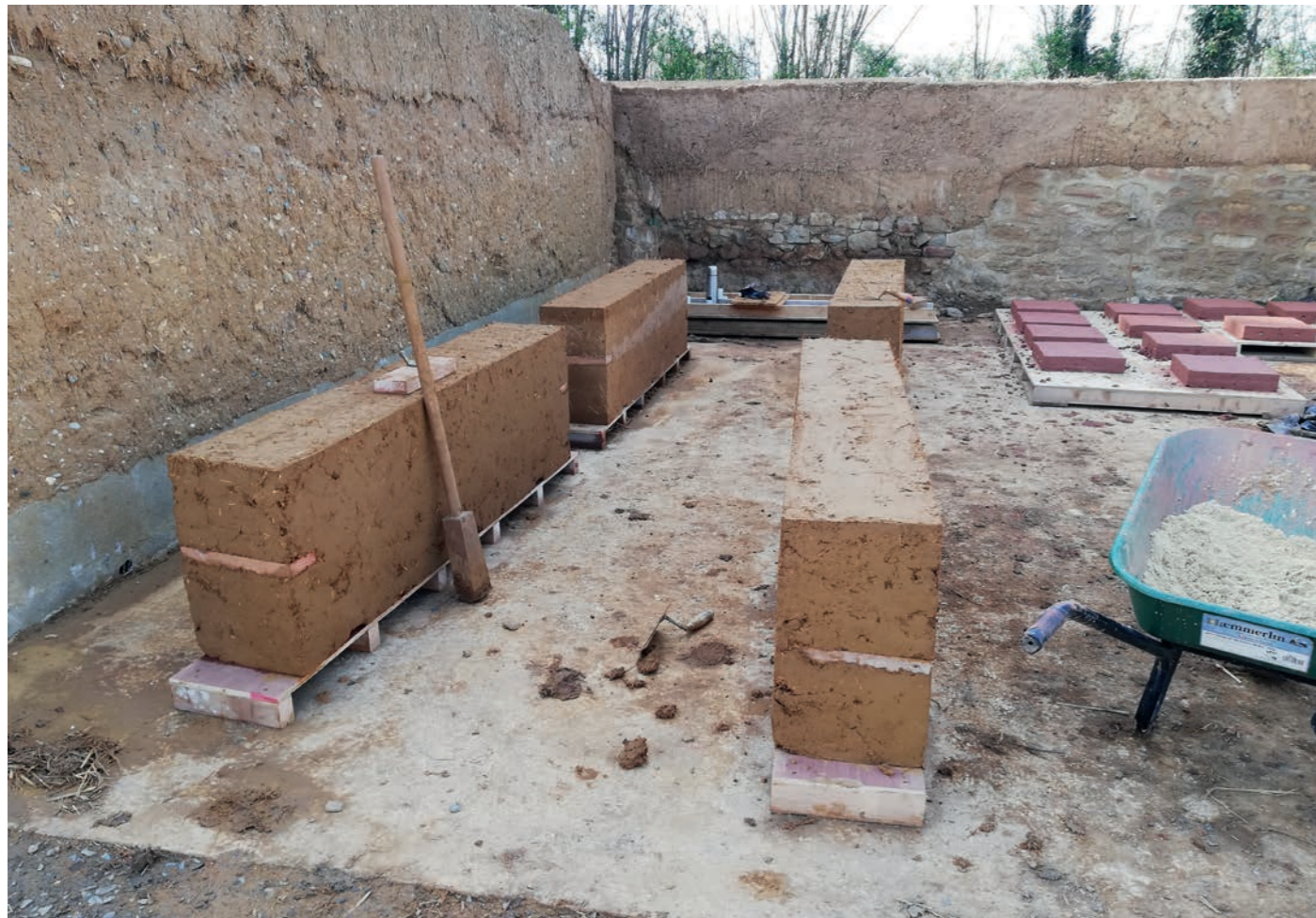
Fig.8 - Fabrication des blocs de bauge du mur trombe du pavillon TEPCV
