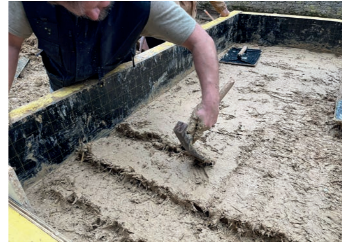
Fig.28 - Texture permettant l'accroche entre les deux parties CobBauge
