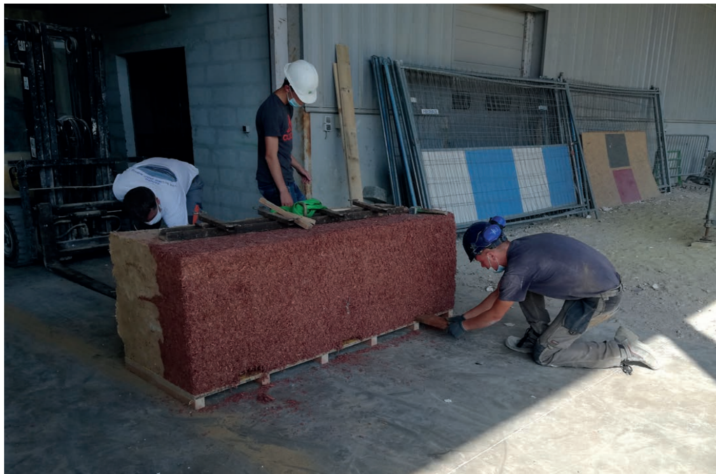
Fig.13 - Mise en œuvre de l'expérimentation du mur CobBauge par les élèves du Lycée technique Laplace de Caen en 2020
