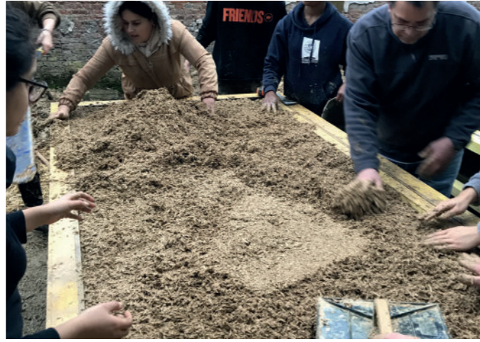
Fig.27 - Étapes du processus de malaxage et de mise en œuvre de la bauge et de la terre allégée par le groupe de fabrique Échelle 1 en 2022
