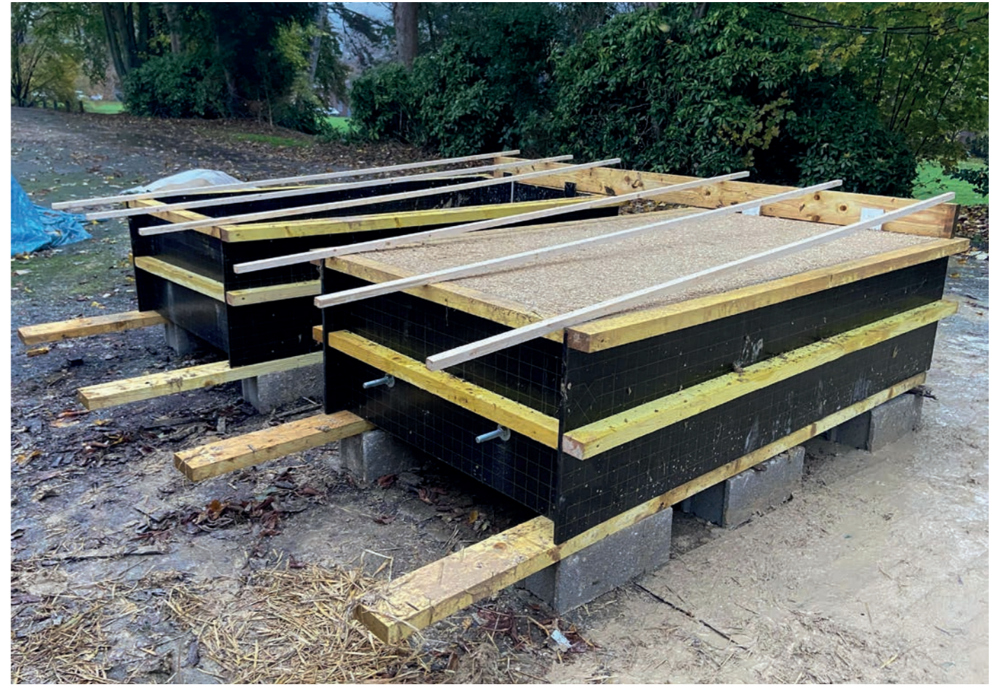
Fig.30 - Séchage des deux blocs CobBauge dans leur coffrage
