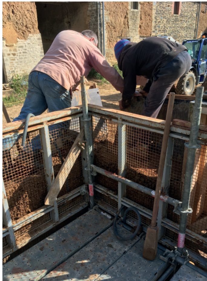
Fig.11 - Coffrage constitué d'un grillage mis au point dans le cadre du projet CobBauge
