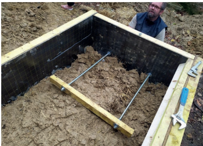
Fig.26 - Étapes de constructions du coffrage dont la mise en place des réserves sur les joues, du dispositif de levage et des grilles par le groupe de fabrique Échelle 1 en 2022
