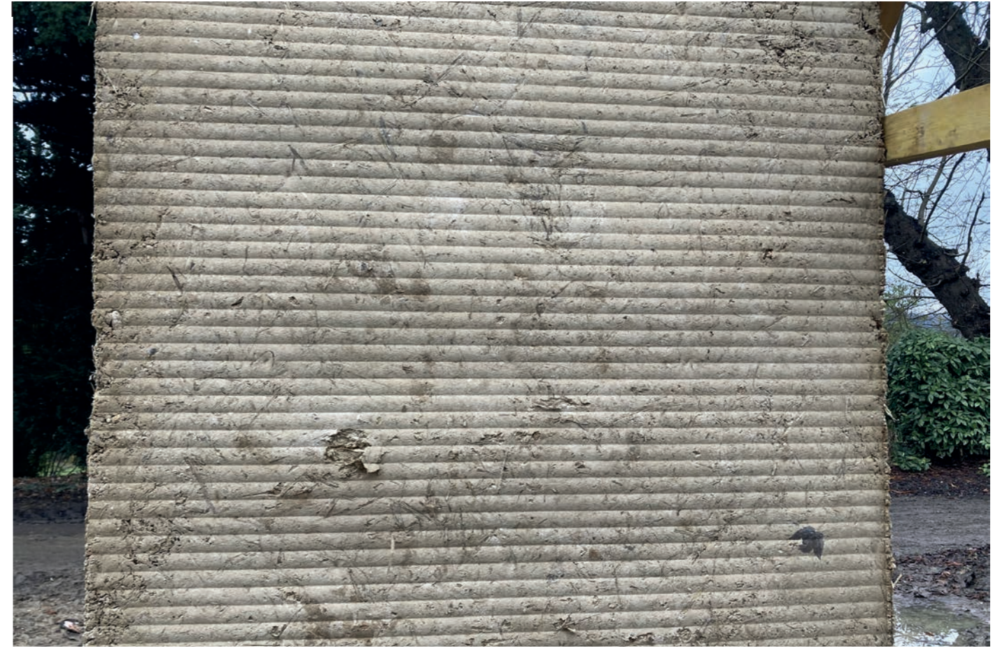
Fig.37 - Façade texturée du mur CobBauge
