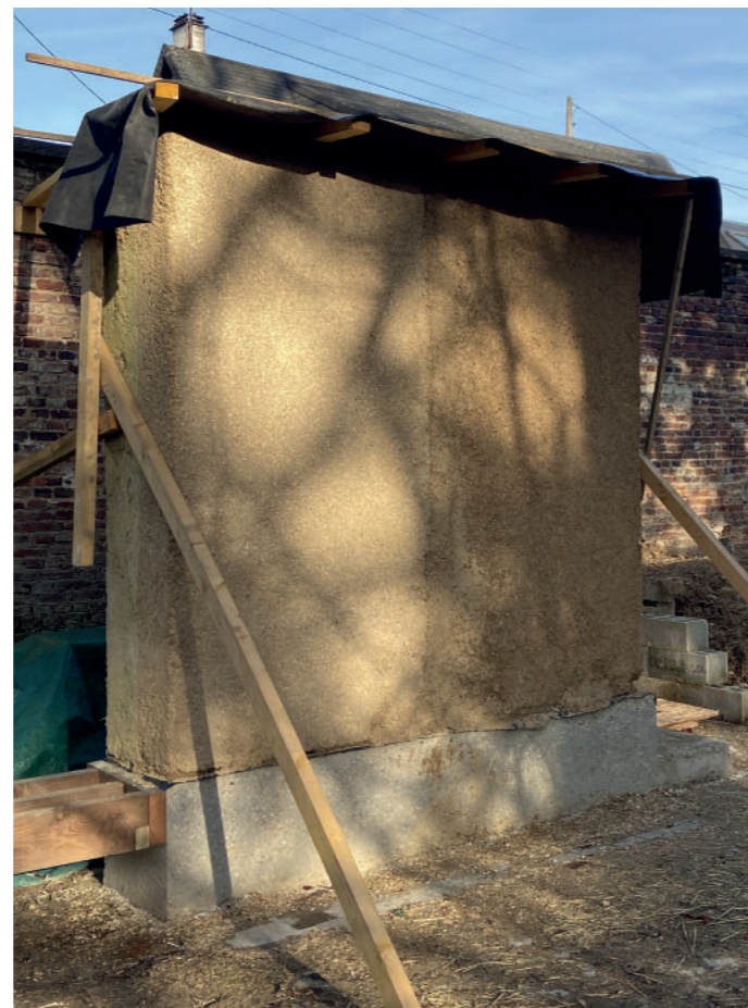
Fig.33 - Assemblage des deux blocs formant un mur CobBauge par le groupe de Fabrique Échelle 1 en 2023
