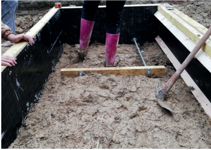
Fig.27 - Étapes du processus de malaxage et de mise en œuvre de la bauge et de la terre allégée par le groupe de fabrique Échelle 1 en 2022
