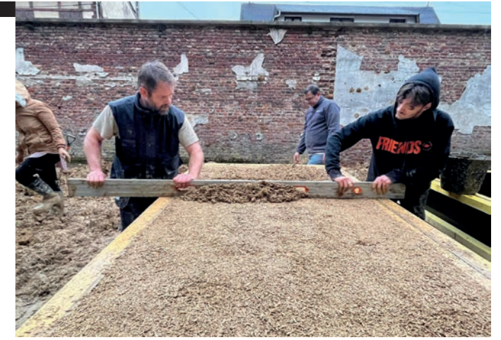
Fig.29 - Lissage de la terre allégée en partie supérieure
