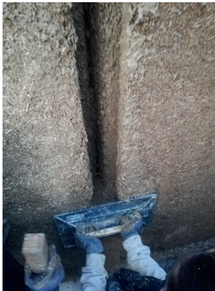
Fig.33 - Assemblage des deux blocs formant un mur CobBauge par le groupe de Fabrique Échelle 1 en 2023
