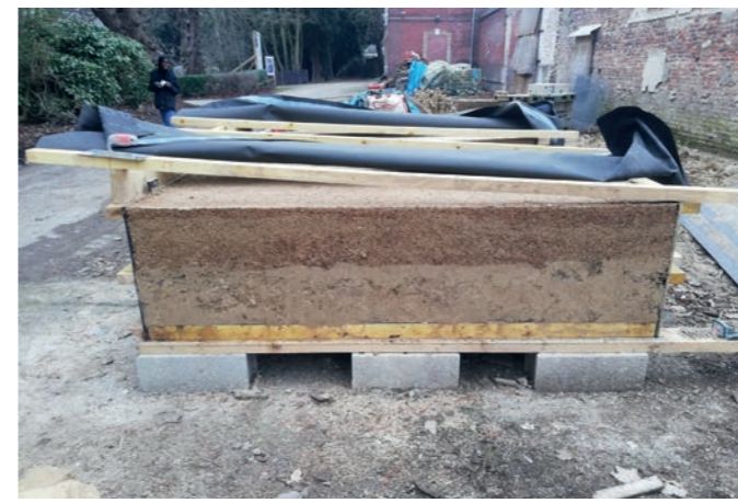
Fig.31 - Décoffrage intermédiaire et vue sur les réserves pour les sangles de levage
