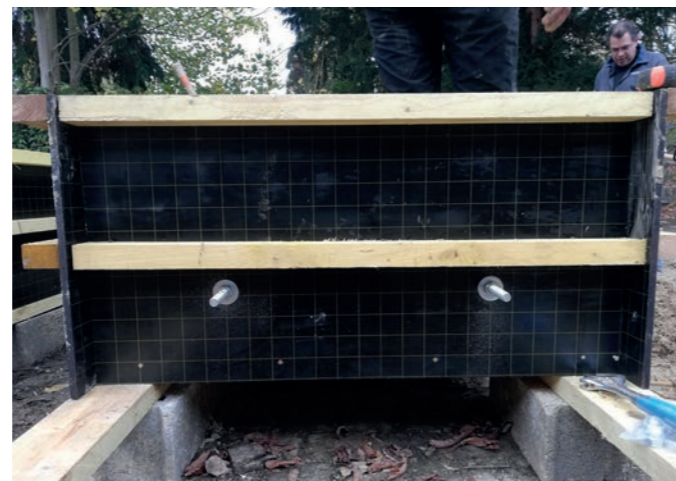
Fig.26 - Étapes de constructions du coffrage dont la mise en place des réserves sur les joues, du dispositif de levage et des grilles par le groupe de fabrique Échelle 1 en 2022
