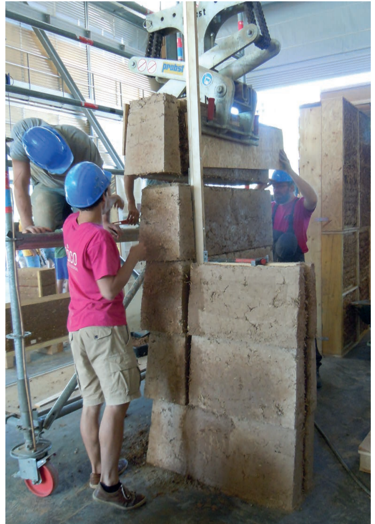
Fig.10 - Assemblage de blocs préfabriqués en bauge réalisés par les étudiants du DSA de CRATerre de l'ENSAG en 2017
