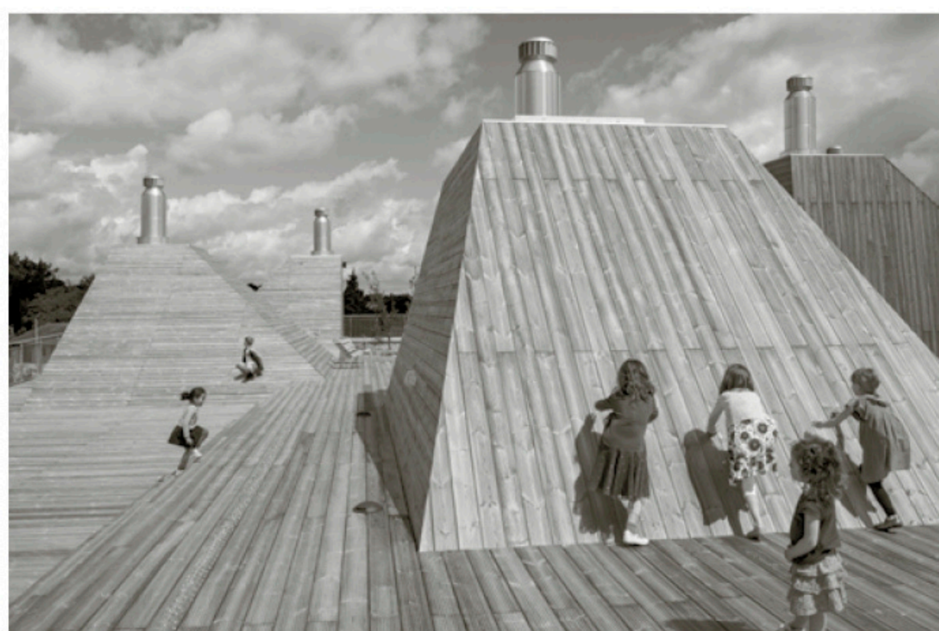
Figure 7 Cheminées de ventilation, Pôle culturel, Cornebarrieu, Atelier Philippe Madec et associés. © Pierre-Yves Brunaud.
