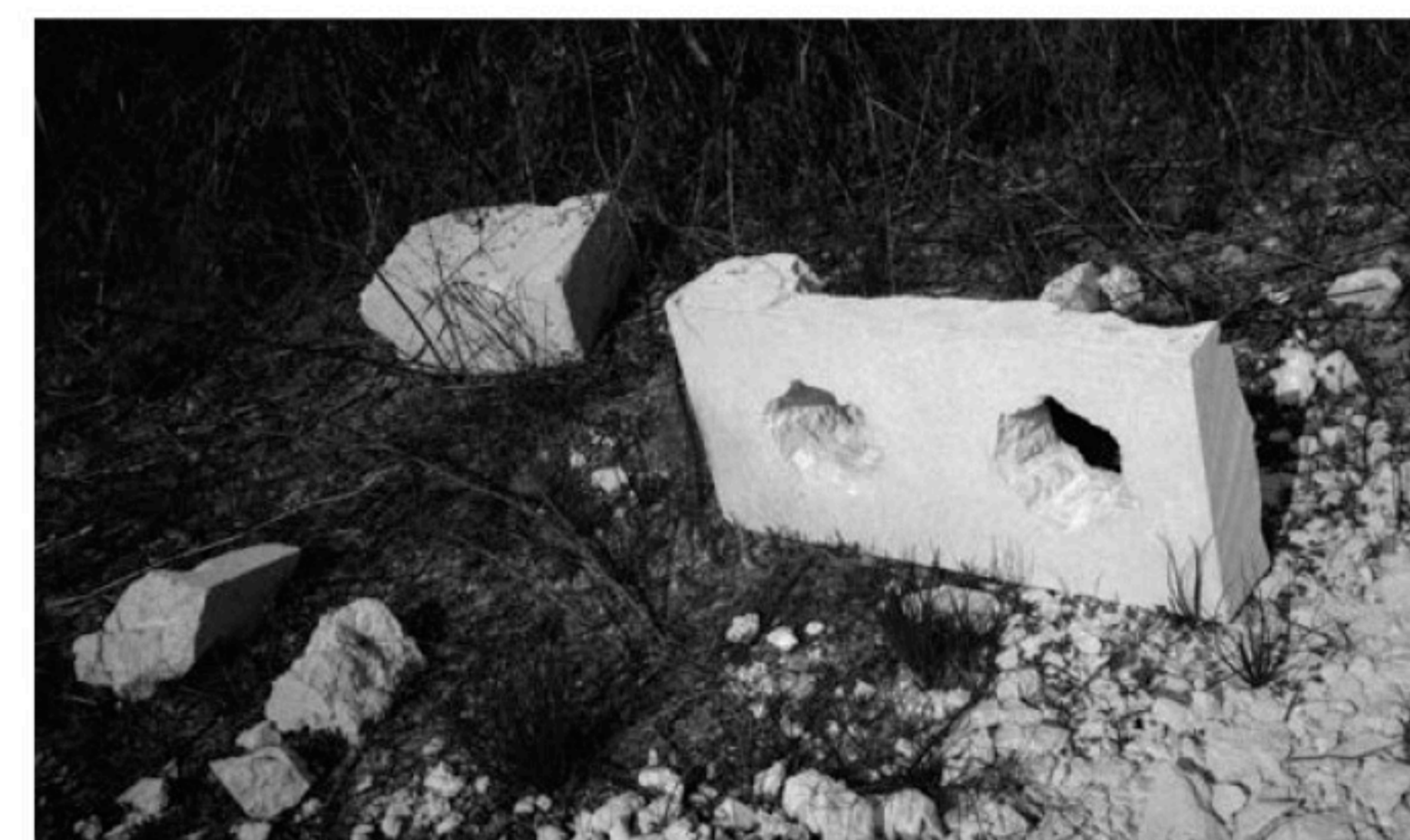
Figure 3 Un bloc de pierre mis au rebut sur le chantier à Campos. Deux perforations dans les blocs qui composent les colonnes servent pour accueillir du béton armé. © Natalia Petkova
