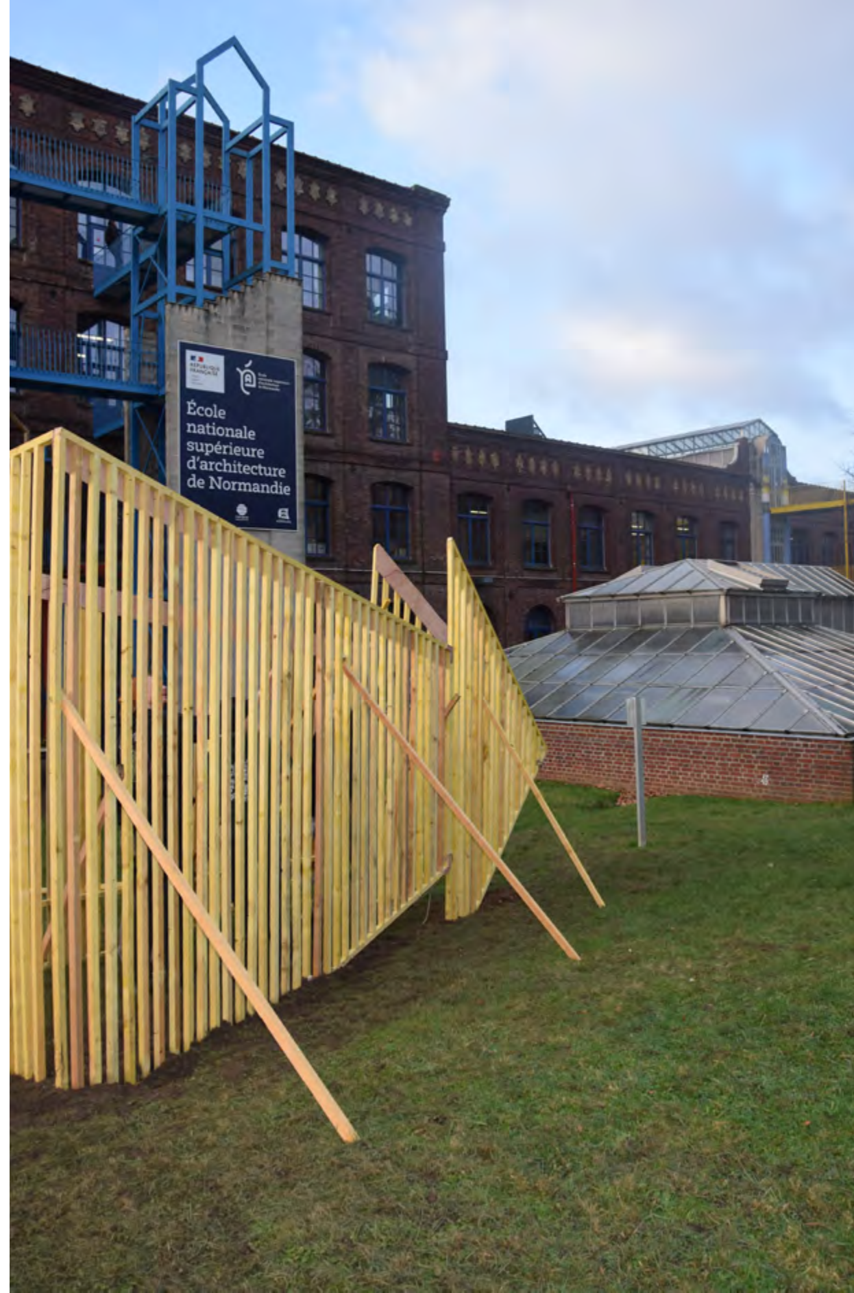
Travaux étudiants - Intensif « Construire » (2024) © ENSA Normandie
