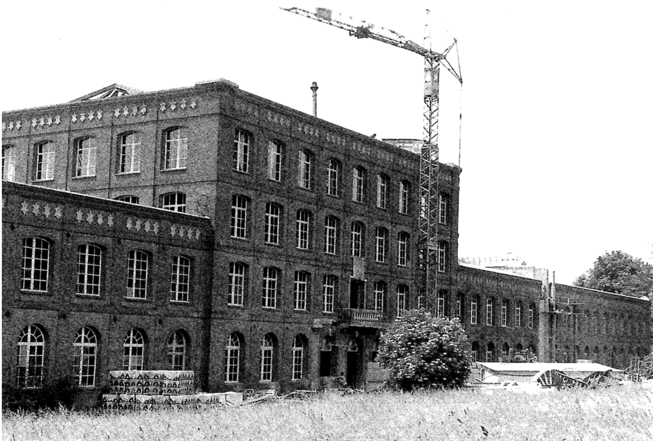
Une grue et un chantier Photographie n.d. (estimée 1982-83) - Fonds ENSA Normandie
