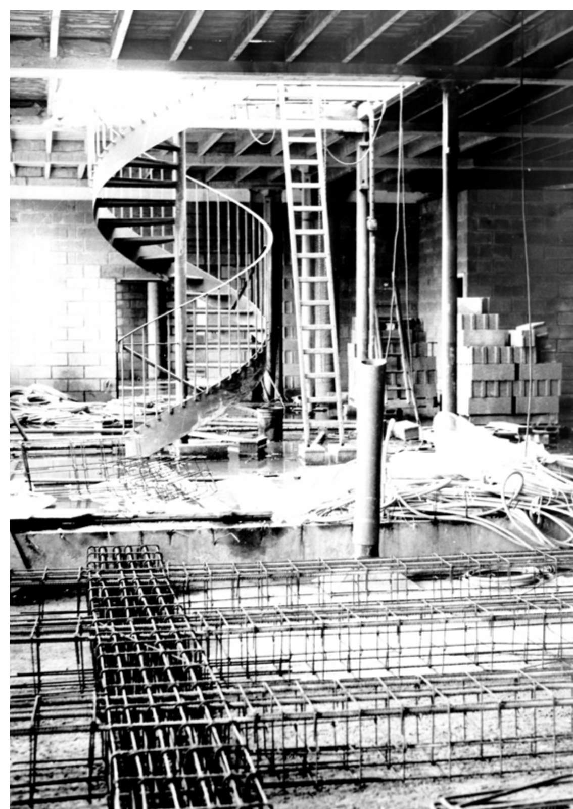
Chantier et coffrage en carton Photographie n.d. (estimée 1982-83) - Fonds ENSA Normandie
