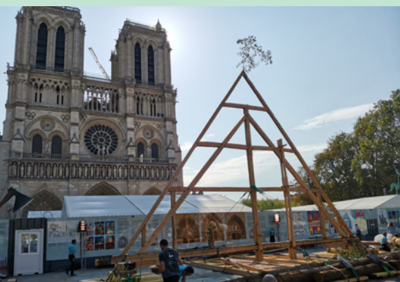
Chantier de Notre-Dame de Paris © D. Vomscheid, 2021
